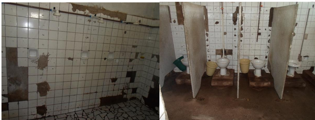
(Ala de Progressão de Itirapina I – Imagem dos banheiros)
