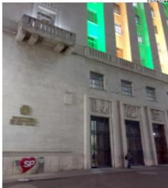
Praça da Prefeitura de São Paulo iluminada nas cores verde e amarela
