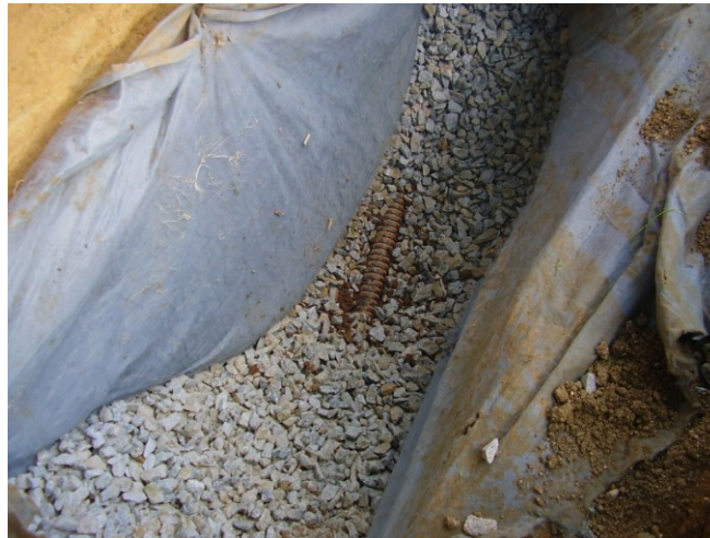
Foto 2 - Manta geotêxtil aplicada na obra de Duplicação da BR-104/PE (Fiscobras 2010)
