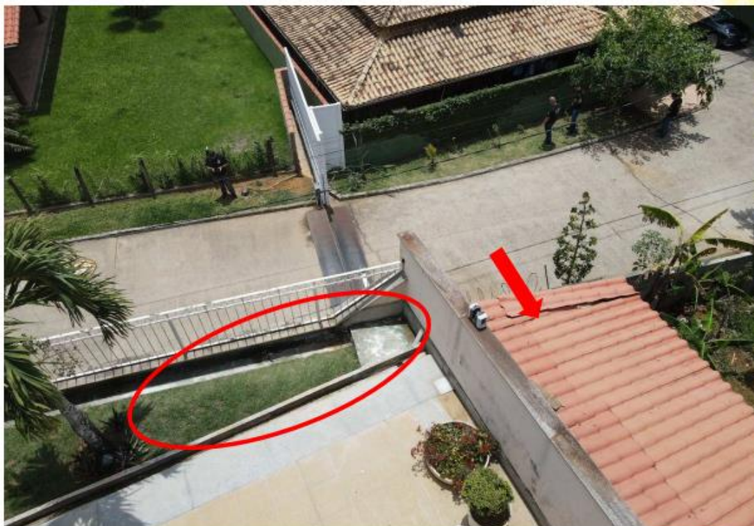
Foto 17: Foto do sublocal 2, com uma elipse demarcando o local onde se encontrava parte dos vestígios, o restante se encontrava no telhado indicado com uma seta
